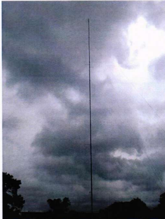
FIG 3. VIEW OF MET MAST
